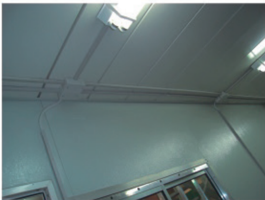
Instalações nos containers da NHJ do Brasil.
